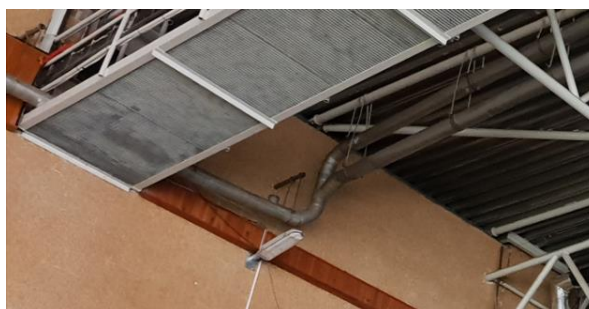
Obr. 2: Demolované ocelové lávky v podstřeší
