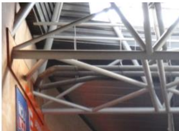
Obr. 5: Ocelové příhradové vazníky
